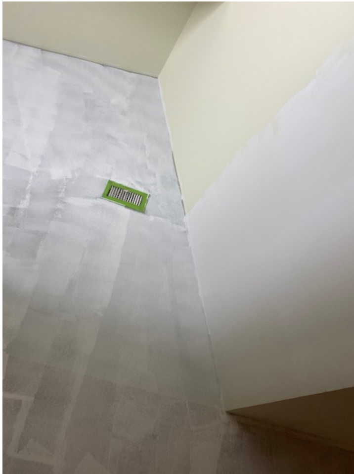
1 st Coat of Primer
