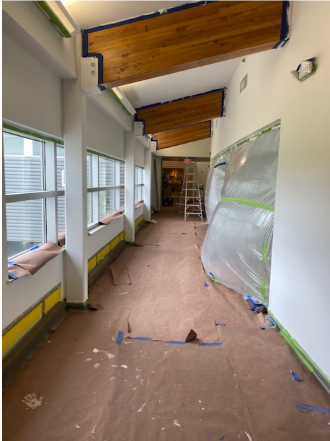
3 rd Coat of Primer
