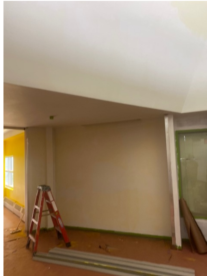
2 nd Coat of Primer
